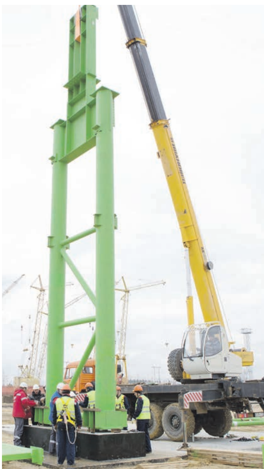
△ Строители установили первую колонну будущего цеха © ВАЛЕРИЙ ПОКУМЕЙКО
