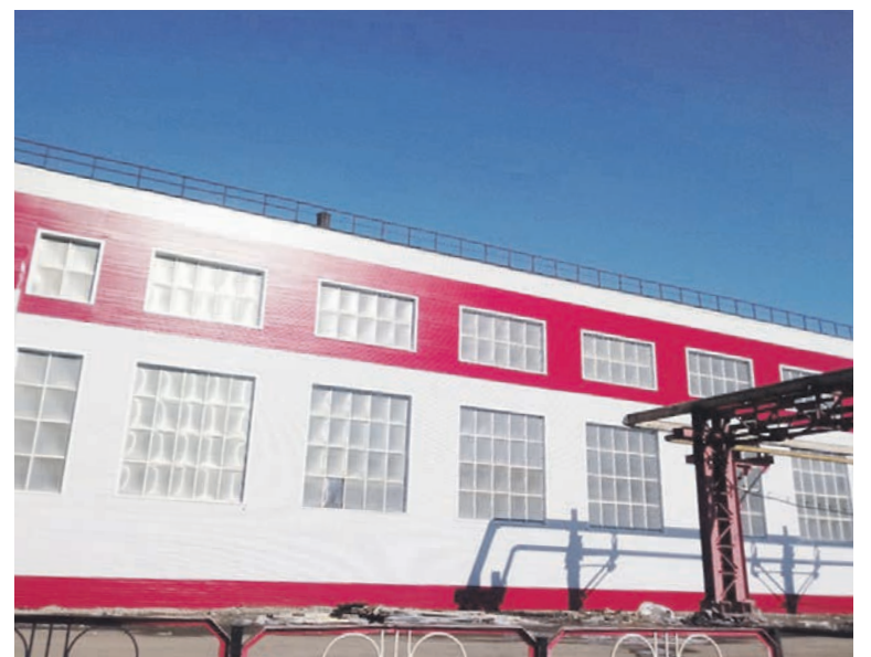
▲ Здание обшили металлическим профилем © ЮРИЙ СОФОНОВ
